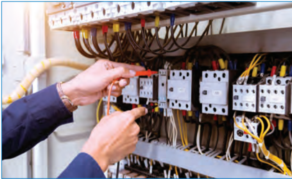
استبدال الصمامات والقواطع
