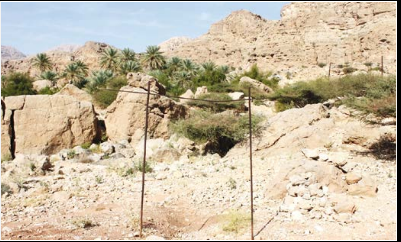
اللمد في فلج أبو من في بلدة كمداء بنيابة قلهاث وهو النوع الثالث من أنواع اللمد في سلطنة عمان ويمتاز بعمودين يصل بينهما عمود ثالث وهو نادر الاستخدام في بقية المحافظات
